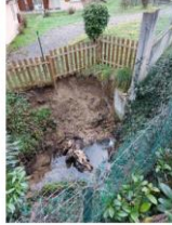
Mur de soutènement
