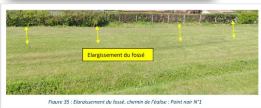
Figure 35 : Elargissement du fossé, chemin de l'église : Point noir N°1
